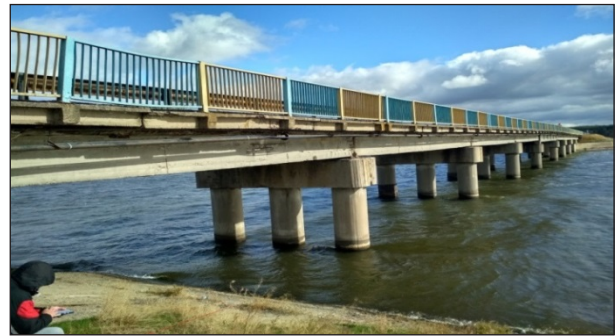
Рис. 3. Фото мостової споруди під реконструкцію
